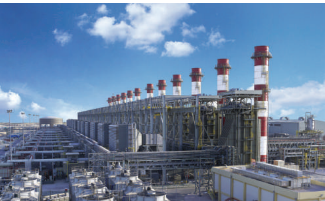
사우디 쿠라야 복합화력발전 세계 최대규모 단일 복합화력 발전소
